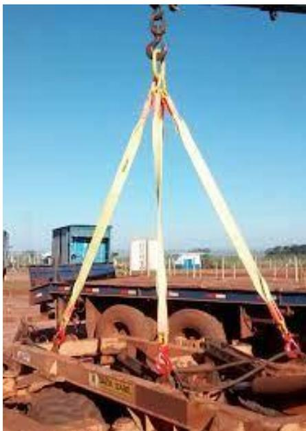
**Figura 15 - Anel de carga conectando pontos de içamento [43]**
