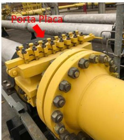
**Figura 21 - Placa de orifício instalada com porta placas**
