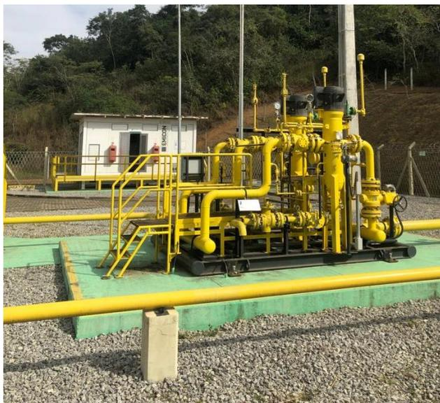
**Figura 14 - Sistema de Controle de Pressão**
