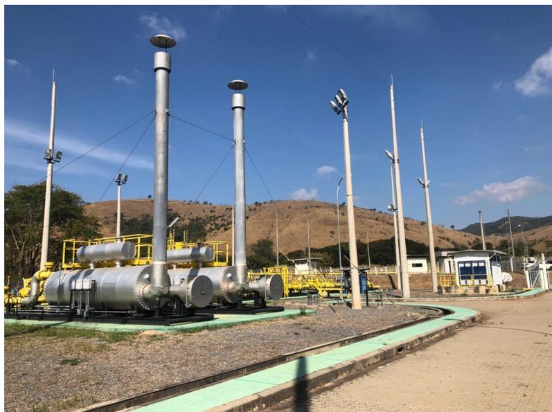
**Figura 12 - Aquecedores em redundância**
