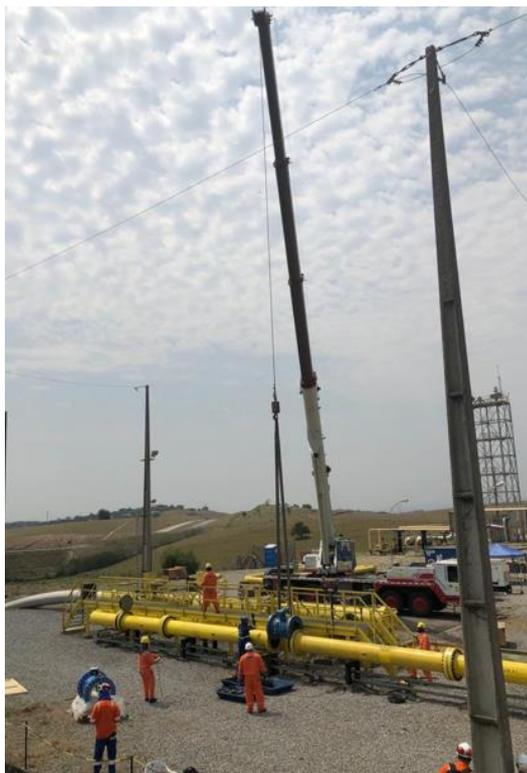
**Figura 28 - Reinstalação de medidor ultrassônico 24"**
