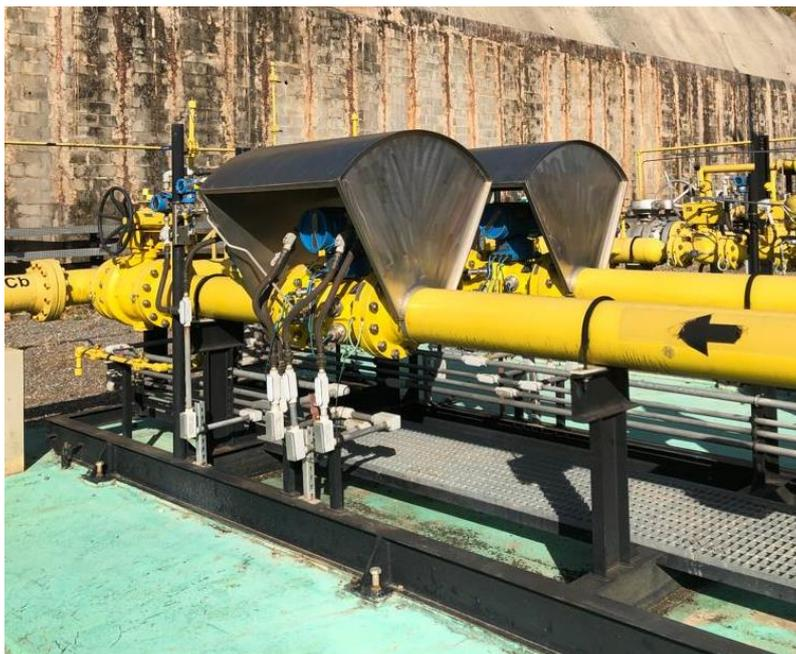
**Figura 16 - Skid de medição com 2 medidores em paralelo**
