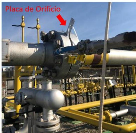
**Figura 20 - Placa de orifício instalada entre flanges**
