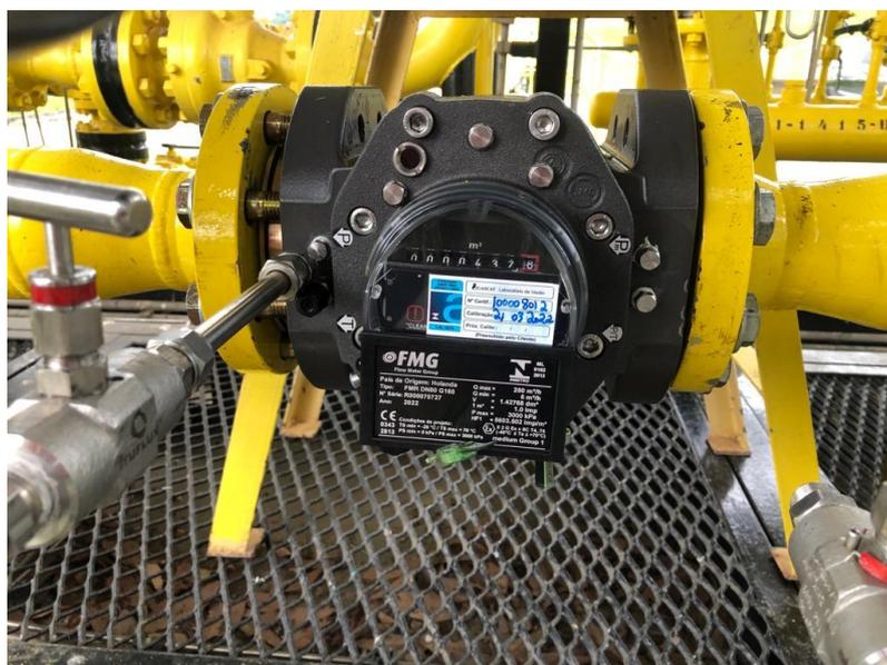
**Figura 26 - Medidor rotativo em operação**
