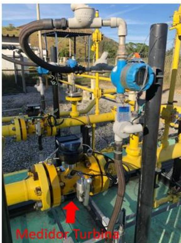
**Figura 23 - Medidor turbina em operação**
