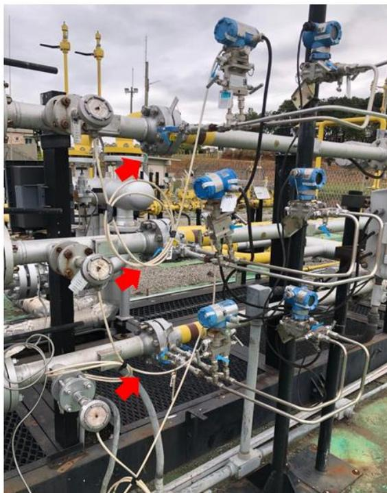
**Figura 17 - Tramos de medição equipados com placa de orifício**
